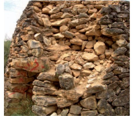
Estado en el que se encontraban las construcciones de Vilamarxant antes de intervenir en ellas. A la izquierda, podemos ver el catxirulo de la partida Cañada Tormos, con los muros de carga totalmente destruidos. Al centro, apreciamos una bóveda derruida que pertenece al aljub caseta dels Tollos. A la derecha, se encuentra el catxirulo de Palones, con parte del muro deshecho y con pintadas en la puerta
