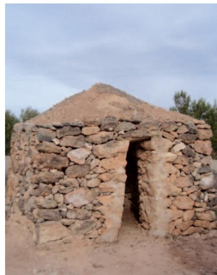
Izquierda, catxirulo de Palones totalmente rehabilitado. En este podemos apreciar como han reconstruido los muros de piedra seca y como han eliminado los grafitos que encontrábamos en los dinteles y las jambas de la puerta. Centro, picapedrero en fase de rehabilitación. Derecha, catxirulo de la partida Cañada Tormos. Totalmente recuperado, a pesar de ser uno de los que se encontraba en peor estado
