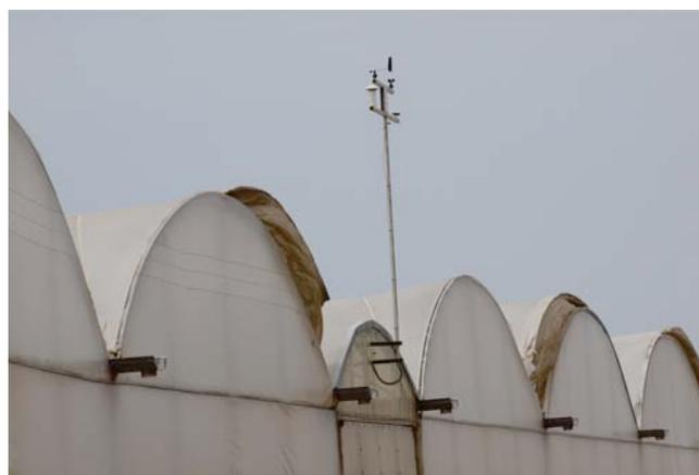
La estructura industrial de tipo multitúnel es una de las más difundidas, con buena hermeticidad y ofreciendo prestaciones adecuadas para la instalación de sistemas automatizados de control ambiental.
