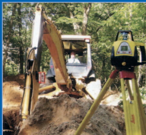
MC200 DEPHMASTER Control visual de profundidad
