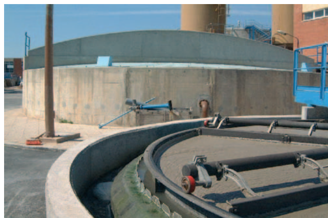
Tanque de espesado de lodos de la Estación Depuradora de Aguas Residuales Urbanas de Castellón de la Plana
